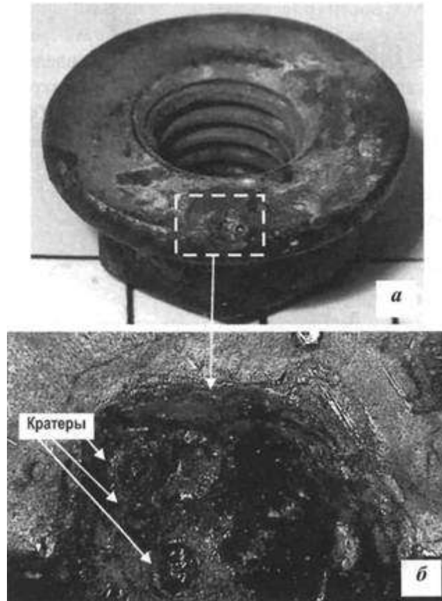
Рис. 30. Гайка (а) и микроструктура ее участка (б) со следами электроэрозии на контактной поверхности (ОМ, 50 × )
